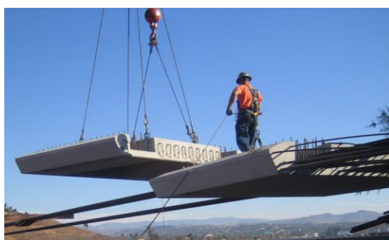
Izvođenje rešenjem prednapregnutih traka („stress ribbon“)
